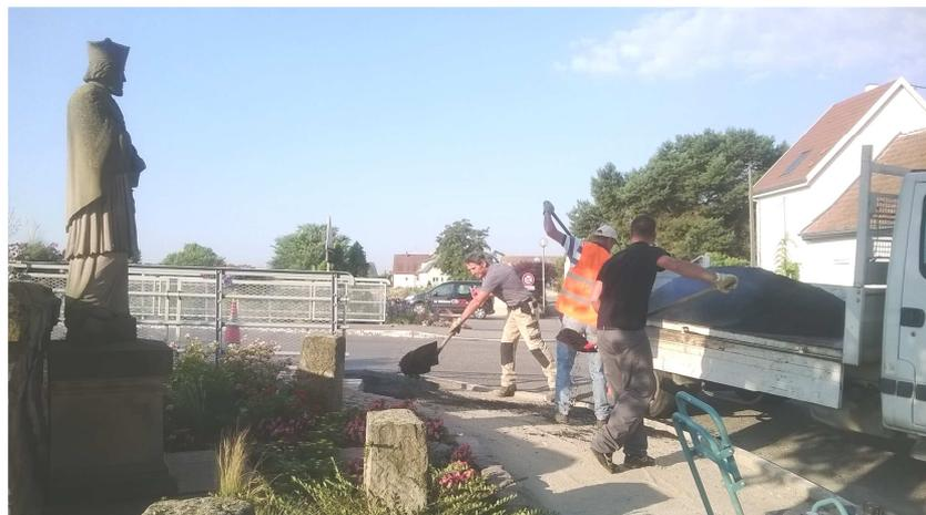
**Pont supérieur de l'III :** pose de pavés sur le trottoir côté rue des Tilleuls et engazonnement. Côté rue de l'III, devant la statue de Népomucène, le trottoir en gravillons a été transformé en zone recouverte d'enrobés.
