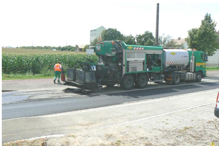
Le Syndicat National du Béton Prêt à l'Emploi a convié ses membres à une journée technique « Élargissement d'une Voirie Rurale grâce à la Technique Béton MACES (Matériaux Auto-Compactants Essorables de Structure) ». La démonstration technique a été effectuée par la Gravière des Elben au Langerzugweg : tout le long du cimetière, le chemin rural a ainsi été élargi. ▶
