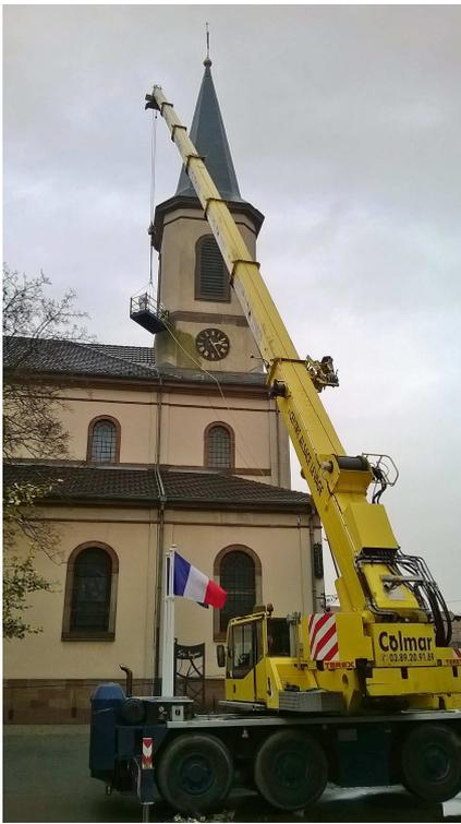
◀ L'entreprise Cheminette de Niederhergheim a réalisé les travaux de nettoyage et d'entretien de l'Église comprenant le nettoyage du nid de cigognes, des gouttières, des réparations de corniche, la mise en place de grillage devant les abat-sons, le nettoyage de la façade. ▶
